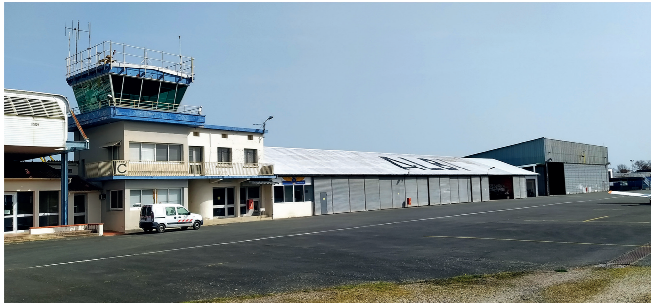
Locaux de l'aérodrome d'Albi, photographie prise depuis le parking, le 01/04/2021
